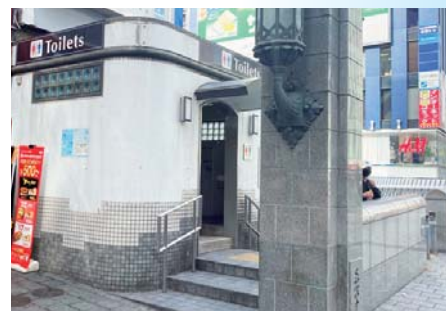
▲現在の戎橋公衆トイレ。
